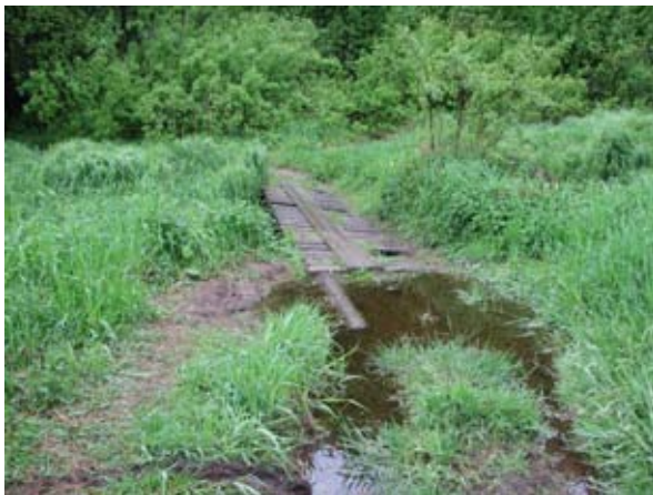
Før utbedring av bro over Biebekken.
