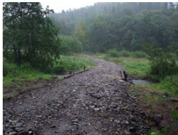
Under anleggsarbeidet. Foto: Aslak Gotehus
