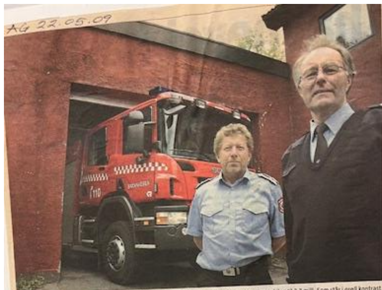
SPLITTER NY: Brannsjef Jan Kongsvik (th) og stasjonssjef Ole Frigstad foran den nye brannbilen til 2,7 mill. Som står i grell kontrast til den utrangerte brannstasjonen bak, som har store synlige sprekker og er etfor trang både til bilpark og de 45 ansatte.
