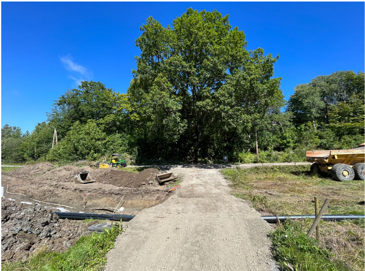
Arendal kommune graver VA-anlegg nær en stor eik ved Gjervoldsøy.
