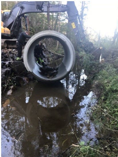
Kulvert legges her ned med stein for å lage gode bunnforhold, og legges dypt slik at passasjen ikke går tørr ved lite nedbør (Foto: Kommunalteknikk).
