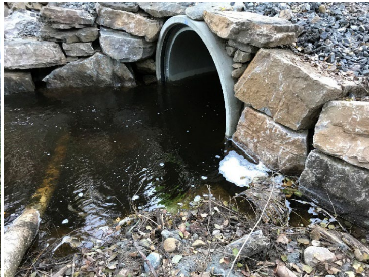
Kulvert legges her ned med stein for å lage gode bunnforhold, og legges dypt slik at passasjen ikke går tørr ved lite nedbør (Foto: Kommunalteknikk).
