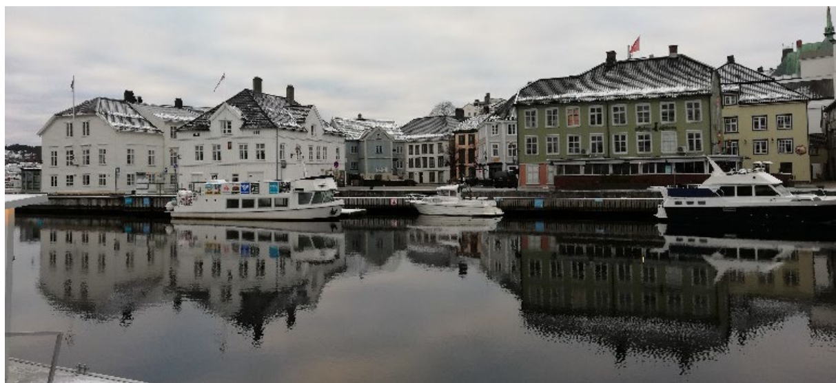
Noen av de eldste bygningene i byen ligger her på Nedre Tyholmen
