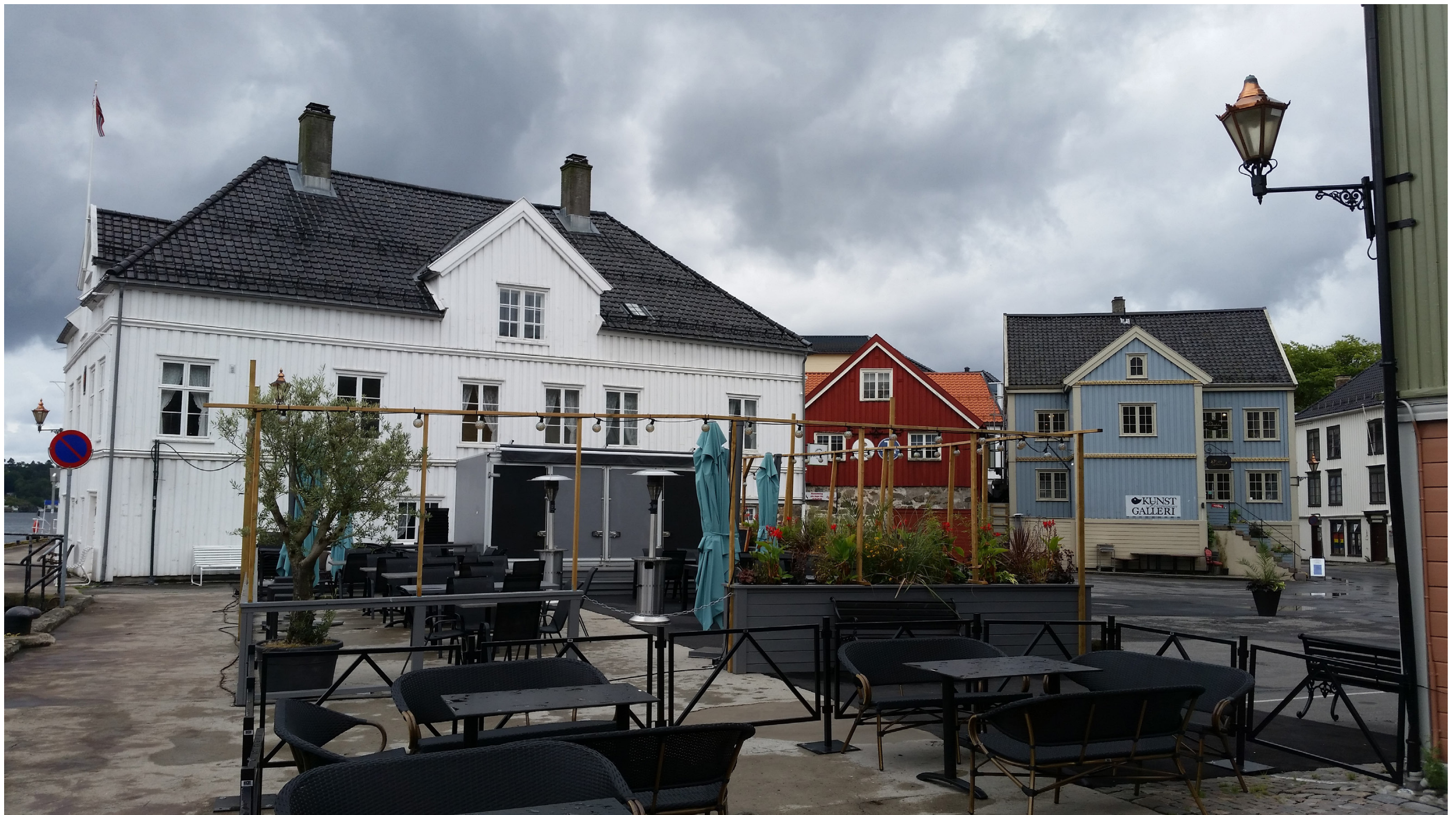
Foto september 2020 - Synlig gammel betongstøp på bakken viser bredde på kaikonstruksjonen. Sjøen kan trolig trekkes inn på plassen uten graving i denne bredden, ved å fjerne deler av betongkaia. Foto viser midlertidig installasjon for servering.
