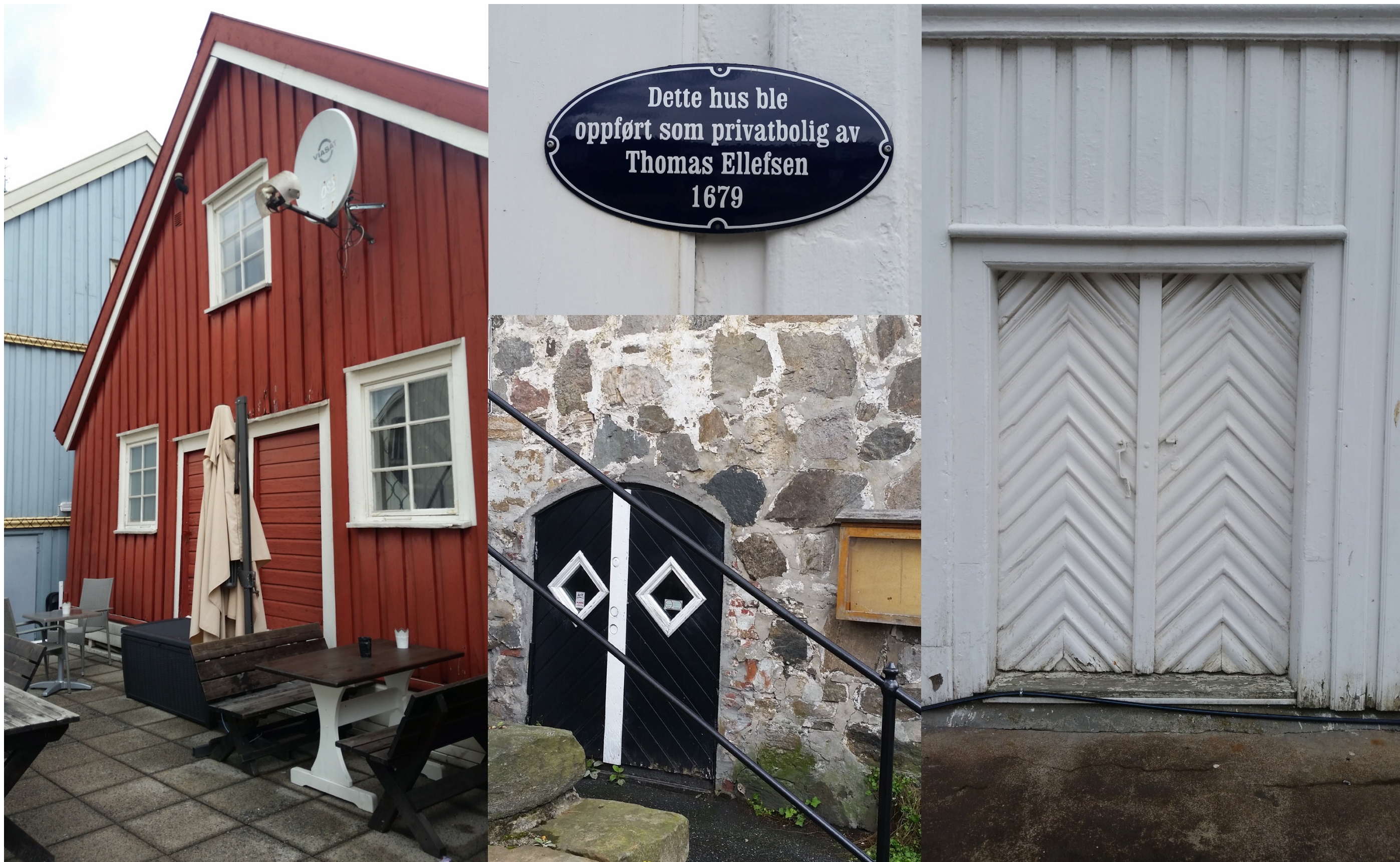
Foto september 2020 - Prosjektområdet har mange autentiske bygningsdetaljer fra tidlig 1700-tall.
