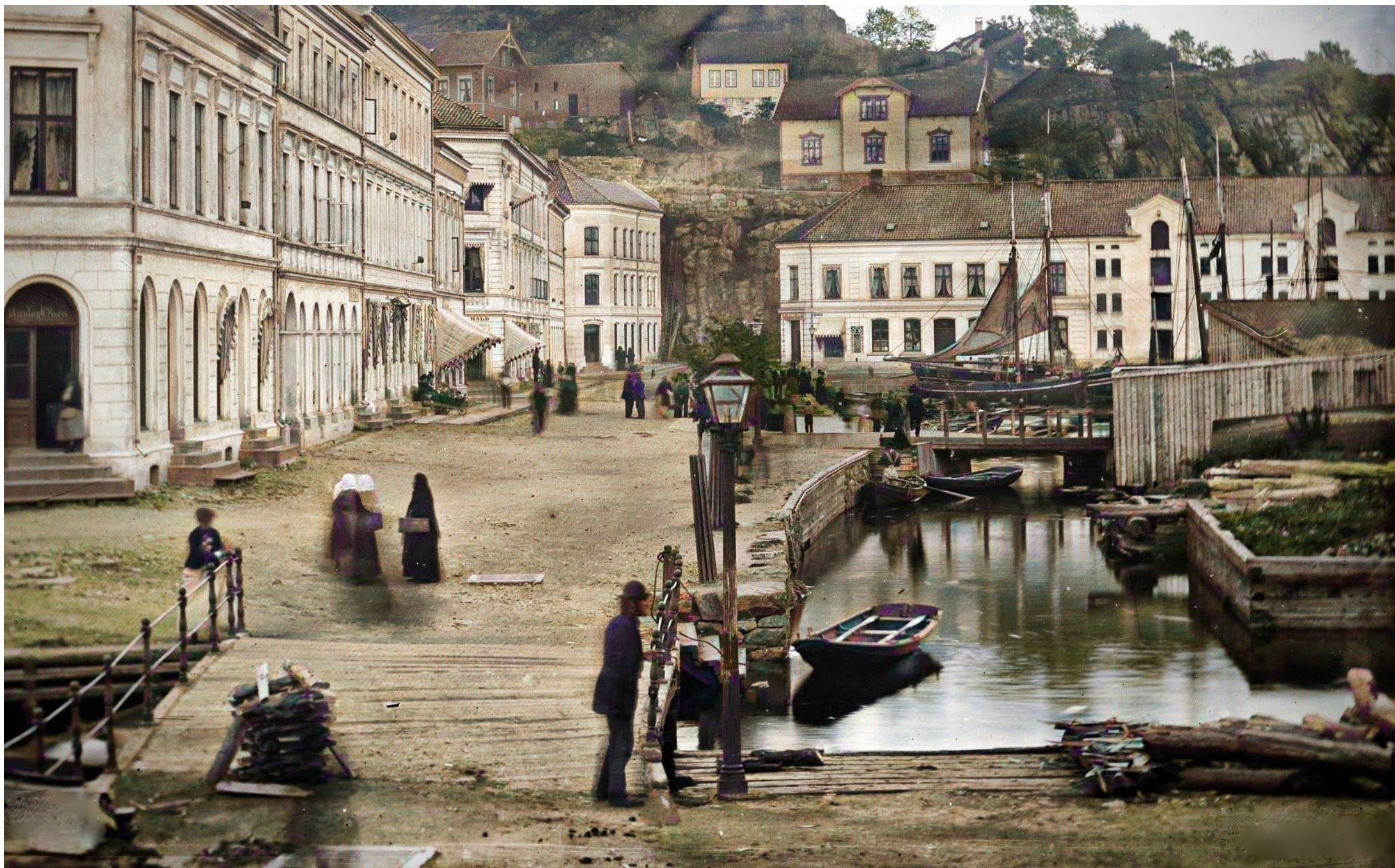
Kanalene ca 1875 - Bruk av tre, ulike varianter av laft og bolverk er benyttet i kanalkonstruksjonen.
