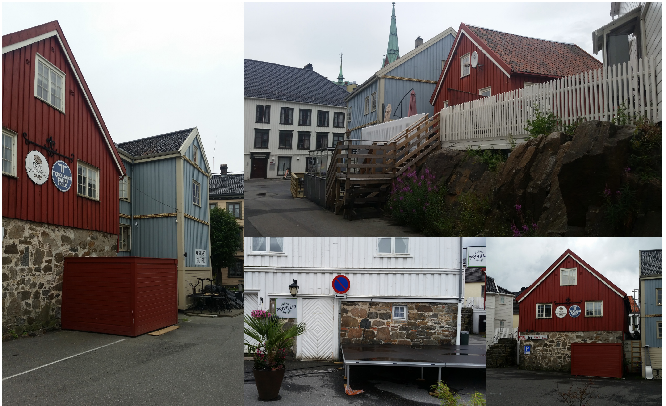
Jaktekaia september 2020 - Kvalitetene kan økes med enkle grep: Opprydding og fjerning av nyere midlertidige elementer med lav kvalitet er ønskelig. Fellesløsning for avfall inn mot steinkjellermuren er svært utheldig utformet og plassert.
