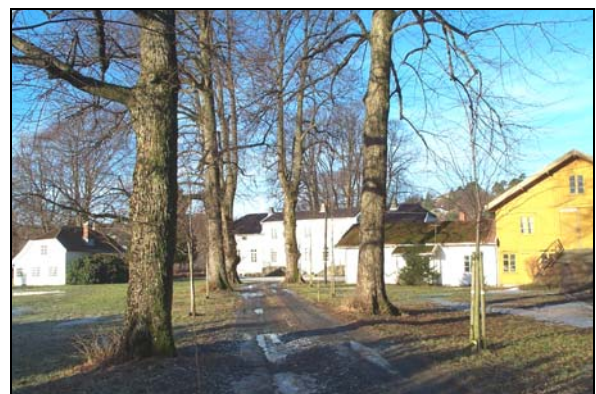
Alléen fører mot hovedbygningen
