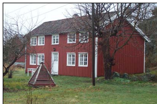
Dette midtgangshuset skal være bygd rundt 1650.
