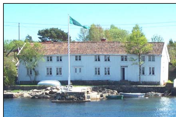
Det eldste huset på Havsøya
